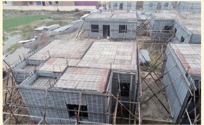
बिहार शरीफ, बिहार में मोनोलीथिक कन्स्ट्रक्शन में स्ट्रक्चरल स्टे इन प्लेस सीआर स्टील फॉर्मवर्क सिस्टम - कोफोर, का उपयोग कर प्रदर्शन आवास परियोजना - प्रगति पर
